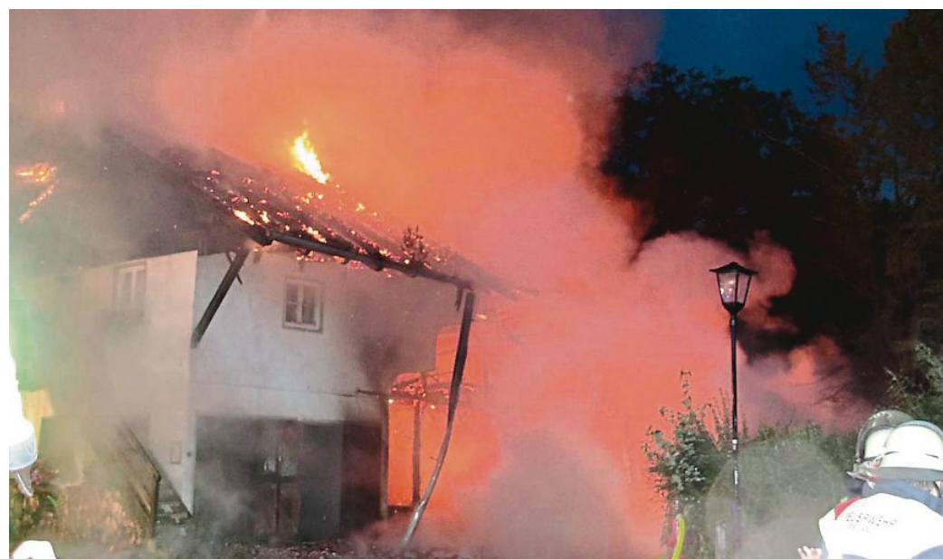
Flammendes Inferno: Im Juli dieses Jahres hatte ein Brand den Schuppen des Gasthofs Kreuzmair sowie ein anliegendes Wohnhaus zerstört. FOTO: ARCHIV RALPH POEPLAU
