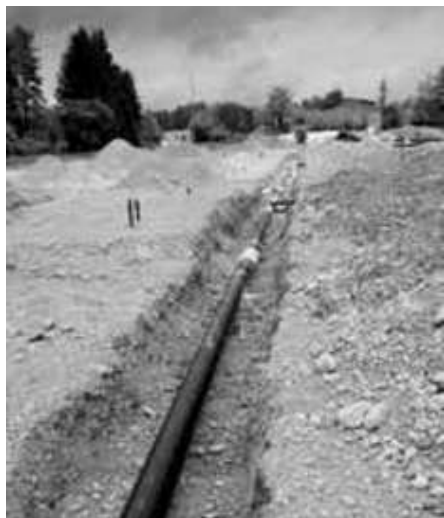
Bei der Verlegung ist die Überdeckung der Leitungen gering. Später, nach dem Bau der Straße beträgt sie 0,8m - 1m.
