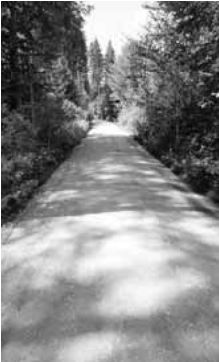
Wegeinstandsetzung in Hartpenning: Gelingene Teamarbeit von Gemeinde, Jagdgenossenschaft und Forstverwaltung. Das hier zu sehende ursprünglich besonders grobsteinige Wege-Teilstück wurde gefräst, gegrädert und gewalzt.
