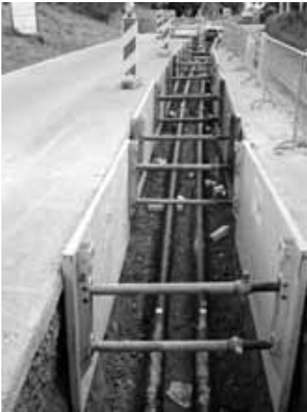
Neue Anschlussleitung in Arbeit
