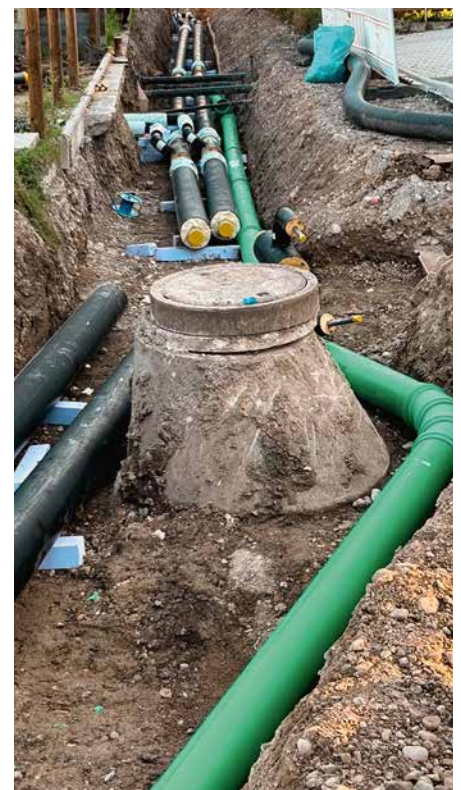
Rohrbauarbeiten am Sternplattenweg
